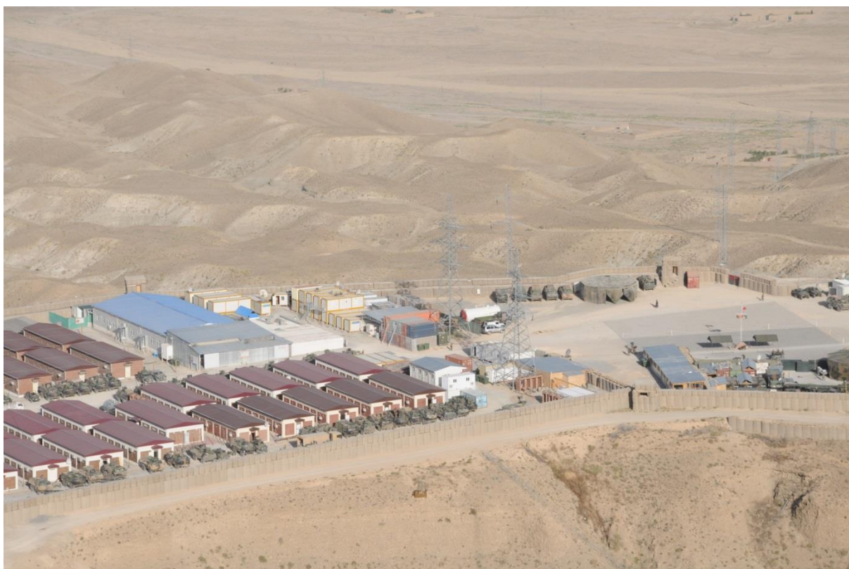
Création d'un camp de base.
